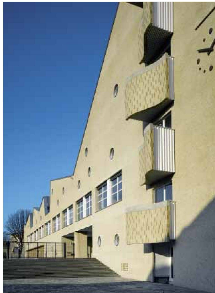
Rau geschlammte Ziegelsteinfassade des Neubaus
