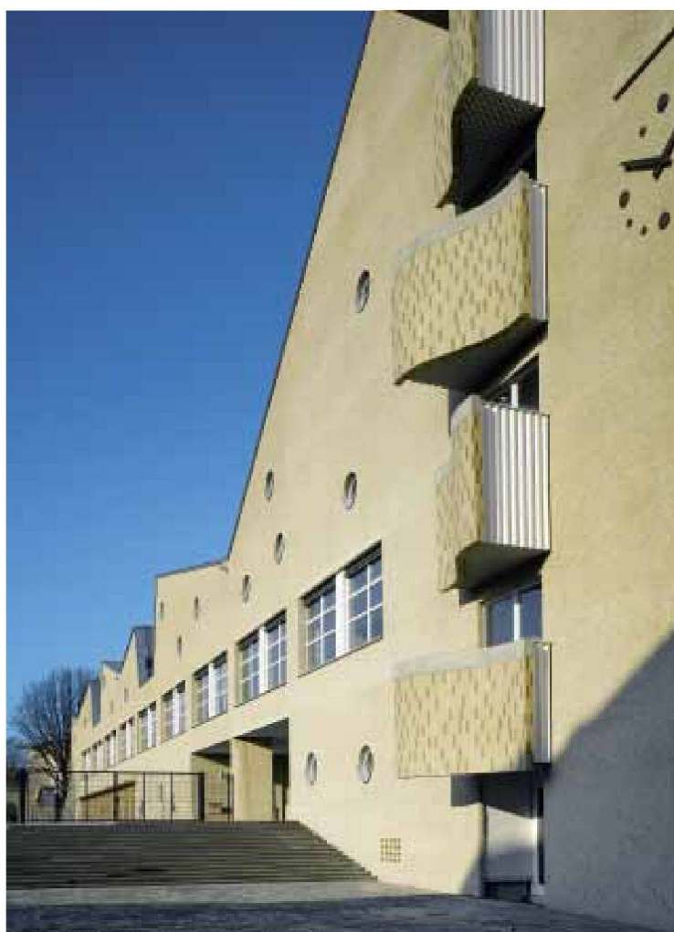
Rau geschlämmte Ziegelsteinfassade des Neubaus
