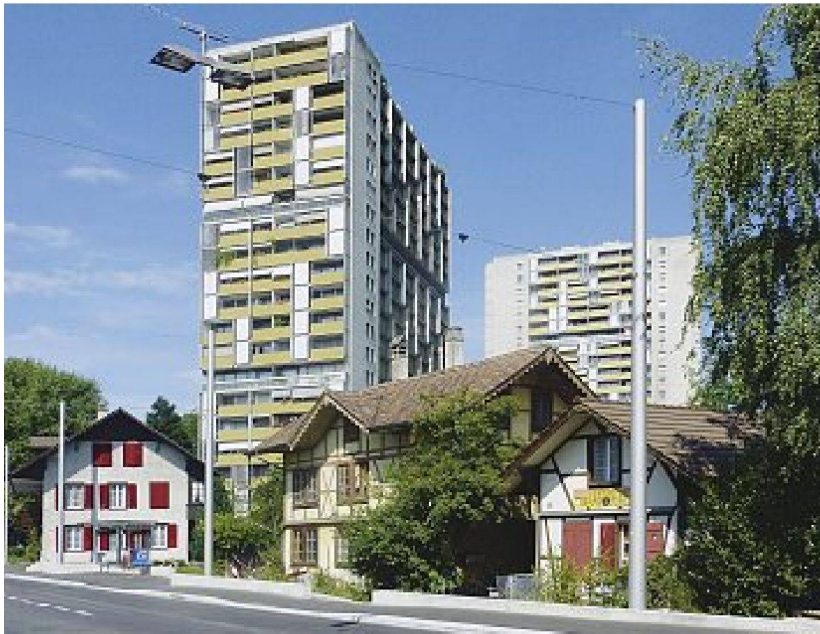
Brüche und Begegnung I. Die beiden Türme des Schwabguts (Rolf Berger, Werner Kuenzi u. a. 1967–1969) haben schon die erste Gesamtanierung hinter sich. Vor ihnen Kleinbauten des späten 19. Jahrhunderts, die sich seit einem halben Jahrhundert dem Abbruch widersetzen.
