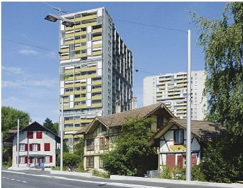
Brüche und Begegnung I. Die beiden Türme des Schwabguts (Rolf Berger, Werner Kuenzi u. a. 1967–1969) haben schon die erste Gesamtanierung hinter sich. Vor ihnen Kleinbauten des späten 19. Jahrhunderts, die sich seit einem halben Jahrhundert dem Abbruch widersetzen.
