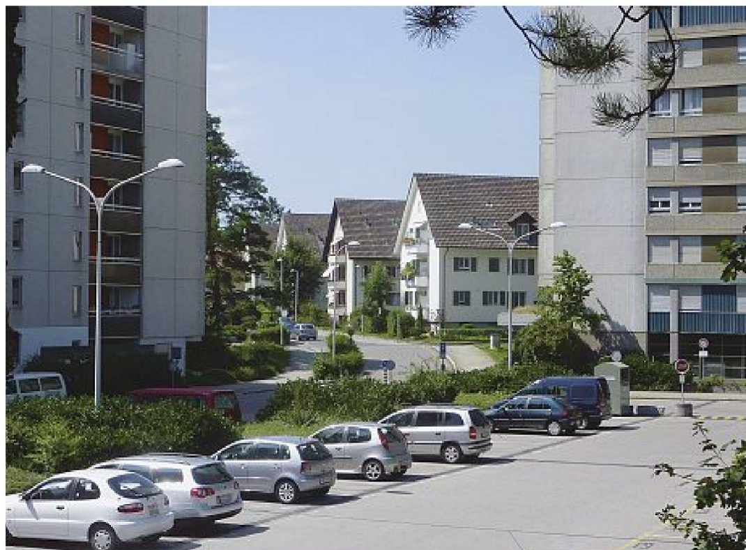
Brüche und Begegnung II. Bümplizer Stilleben. Ausblick vom Fellergut (Hans & Gret Reinhard, Hans Fischli und F. Eichholzer 1969–1977) auf die 1949 von Claire und Oscar Rufer realisierte Überbauung Brünnenstrasse.
