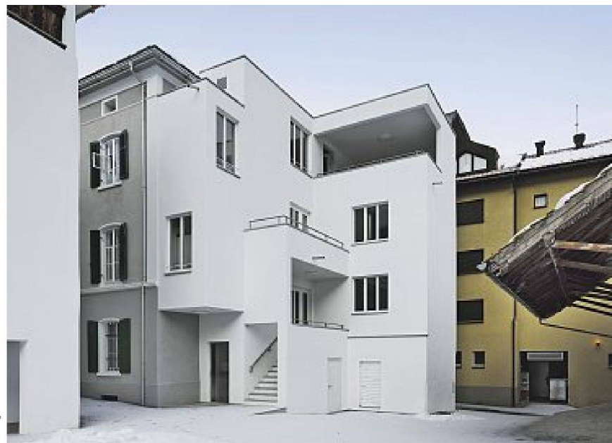
Hofseite mit Hauseingang, Lifteinbau und Terrassenanbau
