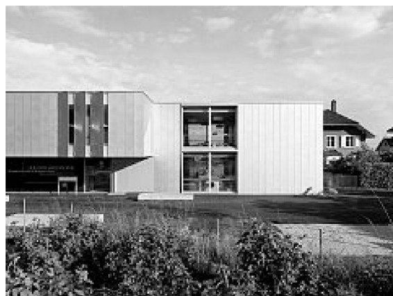
Côté nord du bâtiment
