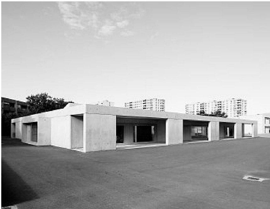
Portique d'entrée depuis le préau
