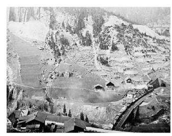
Sicht auf die obere Wattingerbrücke nach 1893. Zur Stabilisierung des Geländes baute die Gotthardbahngesellschaft oberhalb des Bahntrassees unzählige Stützmauern. Die Steinhalde links oben besteht aus Ausbruchmaterial des Naxbergtunnels, der von der Rohrbachbrücke (rechts oben) Richtung Göschenen führt. Bild: Sammlung Verkehrshaus der Schweiz, Luzern
