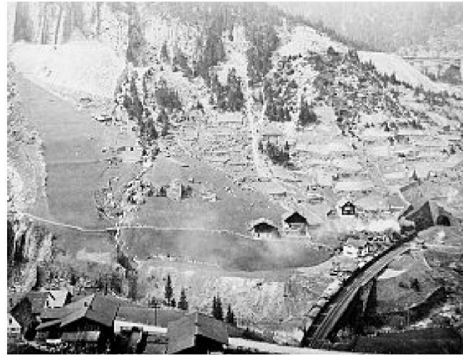
Sicht auf die obere Wattergrabenbrücke nach 1893. Zur Stabilisierung des Geländes baute die Gotthardbahngesellschaft oberhalb des Bahntrassees unzählige Stützmauern. Die Steinhalde links oben besteht aus Ausbruchmaterial des Naxbergtunnels, der von der Rohrbachbrücke (rechts oben) Richtung Göschenen führt. Bild: Sammlung Verkehrshaus der Schweiz, Luzern
