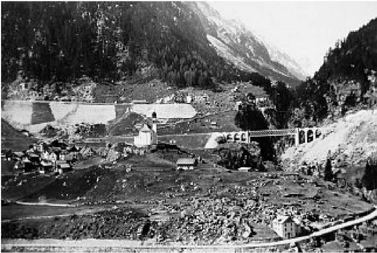
Wassen 1882. Das Bild zeigt die für den Bahnbau vorgenommenen Erdarbeiten und Eingriffe in die Landschaft. Zahlreiche Steinbrüche versorgten den Bahnbau mit Baumaterial und belieferten die Schweiz nach Eröffnung der Bahn mit Granit und Gneis. – Bild: Sammlung Verkehrshaus der Schweiz, Luzern
