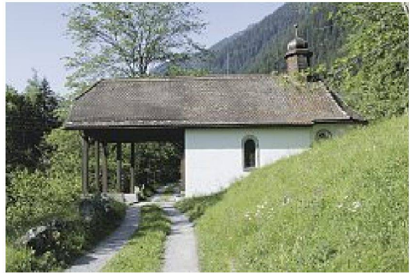
Die St. Josephskapelle bei Wattingen am Saumpfad südlich von Wassen, erb. 1676. Zahlreiche Bauten wie Susten, Brücken, Kapellen oder Brunnen zeichnen die Wege der Verkehrslandschaft Gotthard aus. – Bild: Gottardo-Wanderweg, Ch. Hirtler
