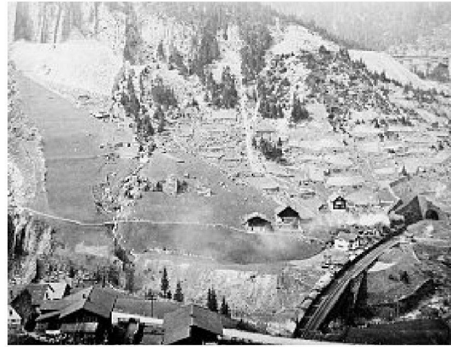
Sicht auf die obere Watteringerbrücke nach 1893. Zur Stabilisierung des Geländes baute die Gotthardbahngesellschaft oberhalb des Bahntrassees unzählige Stützmauern. Die Steinalde links oben besteht aus Ausbruchmaterial des Naxbergtunnels, der von der Rohrbachbrücke (rechts oben) Richtung Göschenen führt. Bild: Sammlung Verkehrshaus der Schweiz, Luzern
