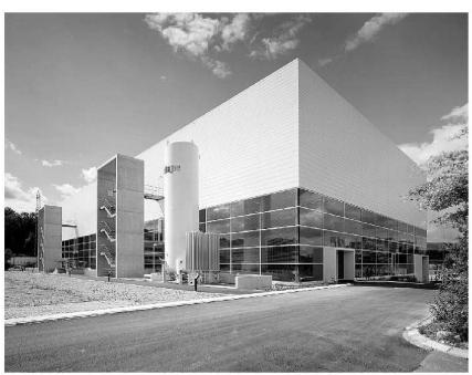
Treppen-, Lift-, und Haustechnikschächte sind tragend ausgeführt und wirken im Verbund mit den Stahlbetondecken als aussteifende Elemente der Konstruktion. Die symmetrisch und klar angelegte Grundstruktur ermöglicht spätere Umbauten ohne Eingriffe in die Tragstruktur.
