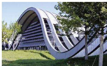
„Das von uns konzipierte Beschattungssystem für das Zentrum Paul Klee war eine totale Neuentwicklung.“
