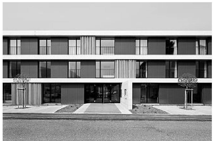
Blick auf den Haupteingang an der Längsfassade
