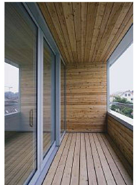
Loggia in sägerohem Lärchenholz
