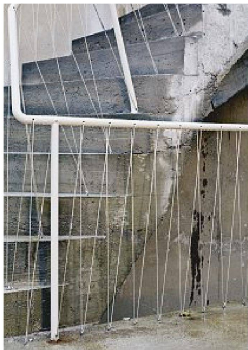
Detail der Aussentreppe auf der Höhe des 2. Obergeschosses. – Bild: Nathan Willock
