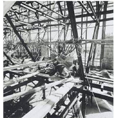
Schalung eines Knotens. – Bild: MRC Archive
