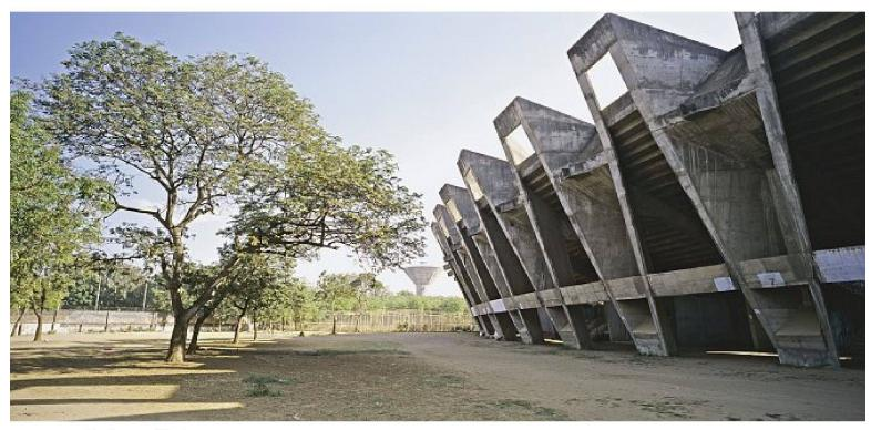
Betonfaltwerk-Segmente bilden die Arena
