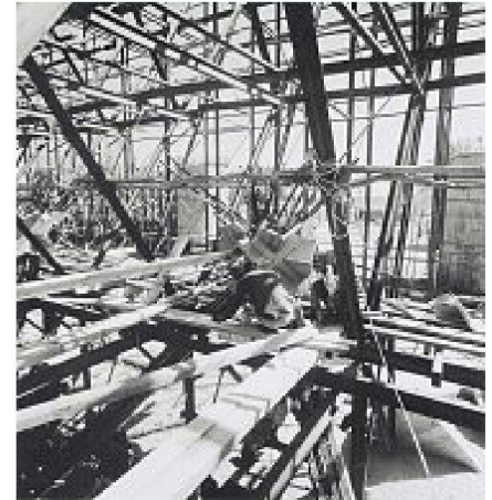
Schalung eines Knotens. – Bild: MRC Archive
