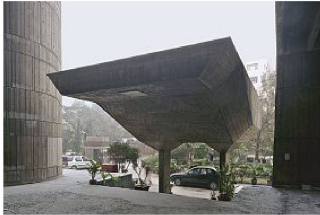
Skulpturales Vordach im Eingangsbereich; die statischen Kräfte werden im freien Erdgeschoss an wenigen Stellen konzentriert.
