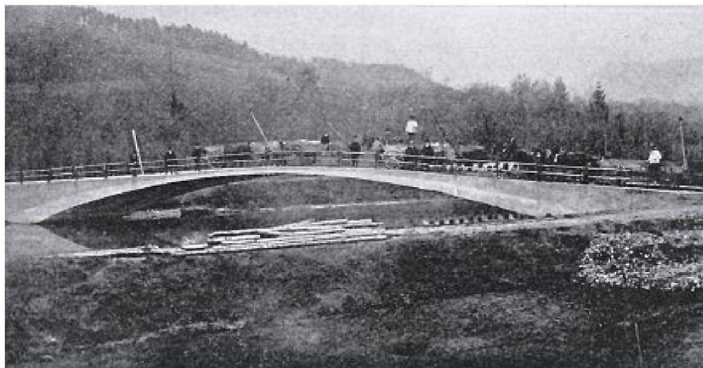
Brücke der Juracementwerke, Wildegg, 1890, nach Belastungsversuchen 1974 abgebrochen. – Bild: Schweizerische Bauzeitung 17(11), 1891, S. 67
