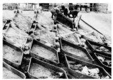
Oben: Lagerhalle in der Via Magliana, Rom (1945): Form und Konstruktion fallen zusammen, weil die Raumhülle aus eine einzigen Material modelliert ist. Unten: Einstellhalle für Landwirtschaftsmaschinen in Torre in Pietra, Rom (1945): Die Drahtzementformen des Dach-Tragwerks werden zur Überprüfung der Geometrie neben der Baustelle auf eine aufgeworfene Negativform aus Erde gelegt.
