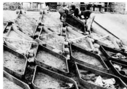
Oben: Lagerhalle in der Via Magliana, Rom (1945): Form und Konstruktion fallen zusammen, weil die Raumhülle aus einem einzigen Material modelliert ist.
