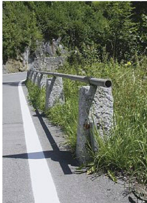
Von oben links im Uhrzeigersinn: Obere Grossgrabenbrücke mit Brüstungs- und Stützmauern – Stützmauer mit Brunnen und gemauertem Durchlass für die Entwässerung – gemauerte Hangwasserfassung mit Durchlass – Kilometerstein 25 mit Wehrsteinen Typ B – Absturzsicherung, Wehrsteine Typ A mit Verbindungsrohren – Strassenrand mit Entwässerungselementen unterhalb der Wendeplatte Heubergrank, Nähe km 27. – Bilder: Isabel Haupt
