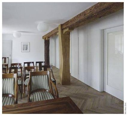
Neue, massive Eichenstützen im Erdgeschoss
