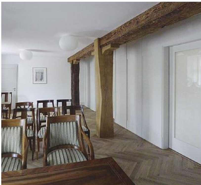
Neue, massive Eichenstützen im Erdgeschoss
