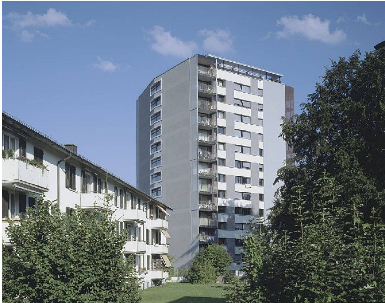
Nach dem Umbau: die neue Raumschicht an der Nordfassade
