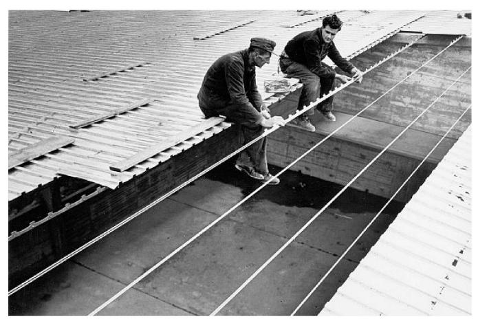
Fural auf Spannstahldrähten. Die Furalhalter sind an doppelt geführte Drähte geklemmt, womit Spannweiten von bis zu 15 m überbrückt werden können. Die Abbildung zeigt vermutlich die Fasslagerhalle der ÖBB in Inzersdorf (A), wo das Dach noch heute existiert. - Bild: Staatsarchiv Uri, Altdorf; PA «Nachlass Josef Furrer-Gisler (1910-1976) / FURAL»
