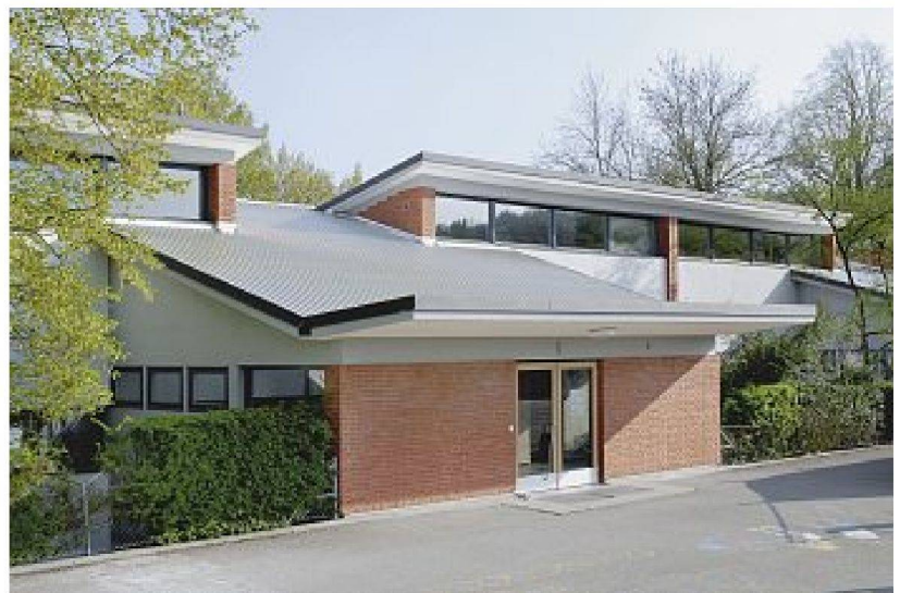
Schulanlage Untermos, Zürich-Altstetten, 1953/54, Architekt Eduard del Fabro; Umnutzung und Instandstellung, 2007–2009, Diethelm & Spillmann Architekten. – Bild: Roger Frei
