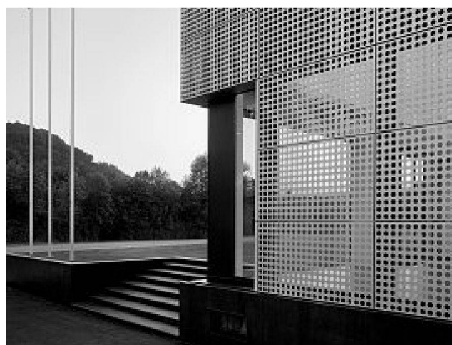
Eloxierbleche bilden die dünne Fassadenhaut.
