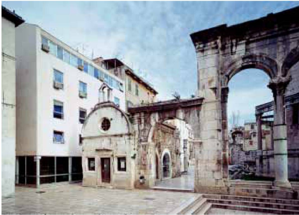
Kroatien: Neven Šegvić, Bürogebäude am Peristyl in Split 1961–1964
