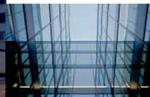
Hartmann setzt visionäre Architektur um: Fassadenbau
