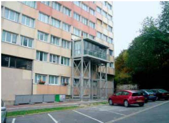
Hochhaus «Tour Bois-le-Prêtre», Prototyp einer Wohnungserweiterung aussen und innen. – Bilder: © Druot, Lacaton & Vassal
