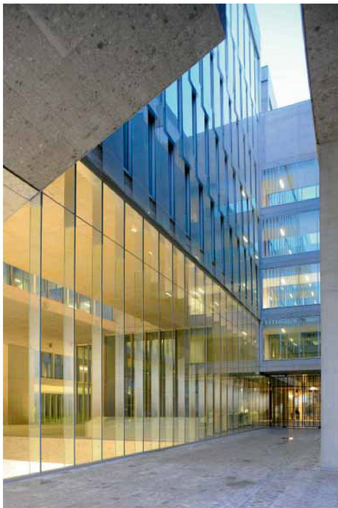
Eingesetzte und abgehängte Glasfüllungen
