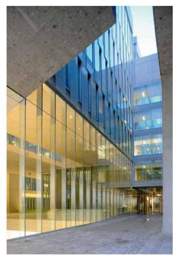
Eingesetzte und abgehängte Glasfüllungen
