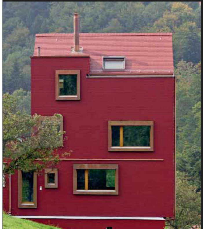
Architekt: Hubert Bischoff , Wolfhalden Dach: DACHSCHIEFER Fassade: FASSADENSCHIEFER
