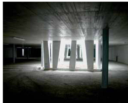
Tiefgarage mit Lichthöfen
