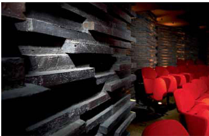
oben: Im grossen Theatersaal des Königlichen Schauspielhauses von Lundgaard & Tranberg sind die Backsteinwände plastisch modelliert, um eine optimale Nachhallzeit zu erreichen. – Bild: Tom Jersø rechte Seite: Die tief eingeschnittenen Öffnungen lassen die Aussenwände des Schauspielhauses massiv wirken. – Bild: Jens M Lindhe
