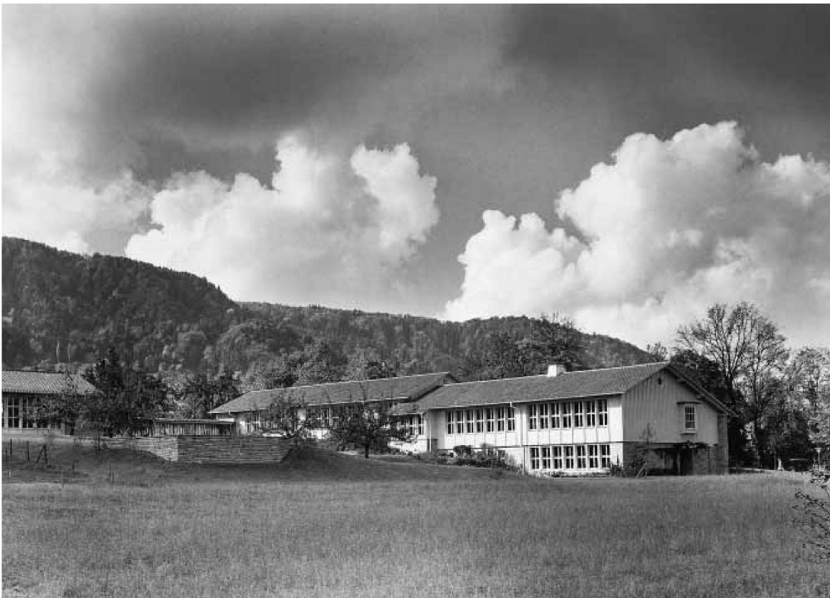
A. H. Steiner, Schulhaus Bachtobel in Zürich, 1947: traditionelle Form, rationelle Bautechnik. – Bild: Rudolf Schmutz, Archiv gta
