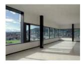
Stossfestigkeit, Luftdurchlässigkeit, Schlagregendichtheit, Luftschalldämmung und Wärmedurchgang sowie Brandschutz und Einbruch. In Systembreiten von 52 und 56 mm lieferbar, erlaubt die Pfosten-Riegel-Technik Glasgewichte bis 700 kg und eignet sich sowohl für den Wohn- und Geschäftshausbau wie für Infrastrukturbauten.
