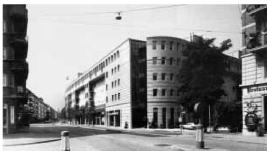
Ueli Marbach und Arthur Rüegg, Wohnüberbauung Manessehof, Zürich 1977–84. Bild: Heinrich Helfenstein
