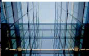
Hartmann setzt visionäre Architektur um: Fassadenbau
