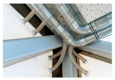
Flexschläuche und Stahlstützen
