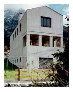
schicht freigelegt ist. Der plastischen Ausformulierung der architektonischen Elemente wird sorgfältig das Netzwerk von Schalungsfugen und Betonieretappen überlagert, was zu spannungsvollen Kongruenzen hier und Verschiebungen dort führt. Gerade die schroffe Nordfassade des Hauses, die in Erwartung eines Nachbargebäudes geschlossen gehalten ist, bezieht viel von ihrer Lebendigkeit aus der Präsenz des Materials und seiner Verarbeitung.
