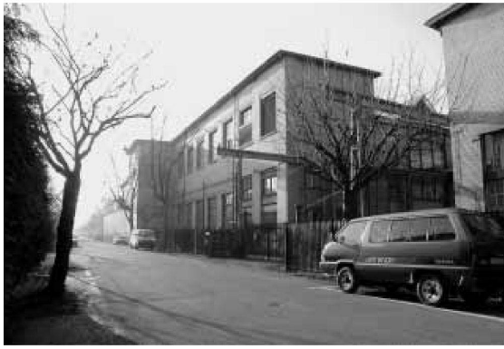
Agnesstrasse, Bestand vor dem Eingriff. – Bild: Knapkiewicz & Fickert Rechts: An der oberen Briggerstrasse
