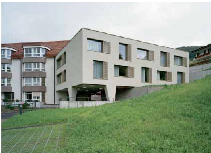
Alters- und Pflegeheim Homburg in Läfelfingen von Boegli Kramp Architekten
