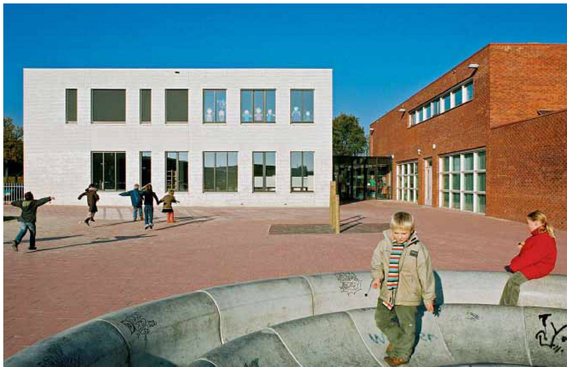
Schulwohnungen in Breda von Baudoin van Alphen. – Bild: Riesjard Schropp
