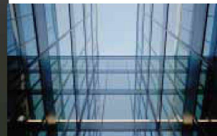
Hartmann setzt visionäre Architektur um: Fassadenbau
