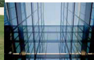
Hartmann setzt visionäre Architektur um: Fassadenbau
