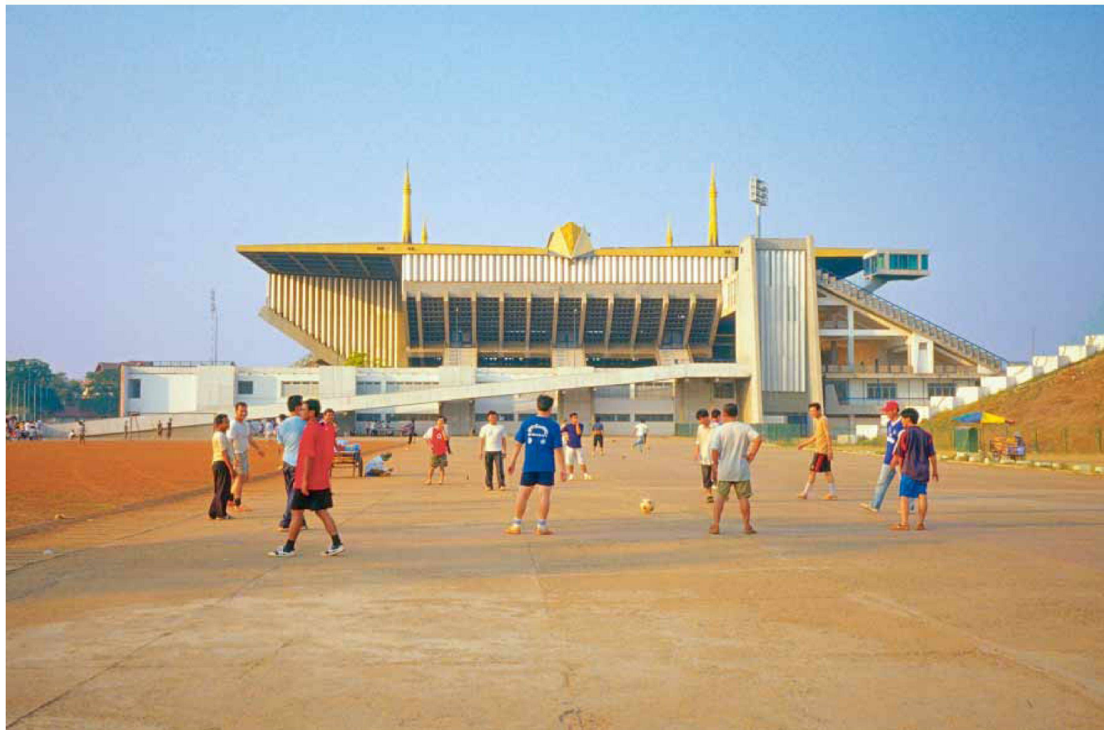
Vann Molyvann, Nationalstadion und Sports Complex in Phnom Penh, 1963/64. – Bild: K. Stehrenberger, A. Flury 2005. Oben: Flugaufnahme des Stadions mit elliptischer Sitzkronenstufe. – Bild: R. Cauchetier
