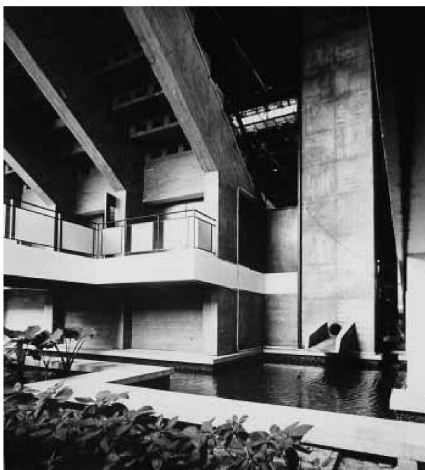
Sporthalle, Pfeilerfuss. – Bild: Archiv Vann Molyvann
