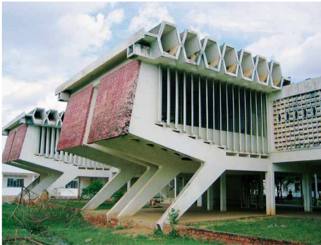
Spezialhörsäle, vom Boden abgehoben. – Bilder: K. Stehrenberger und A. Flury 2005
