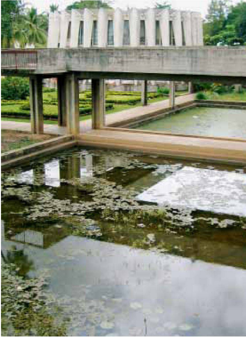
Der «Elevated walkway level» verbindet alle Bauten auf dem Campus
