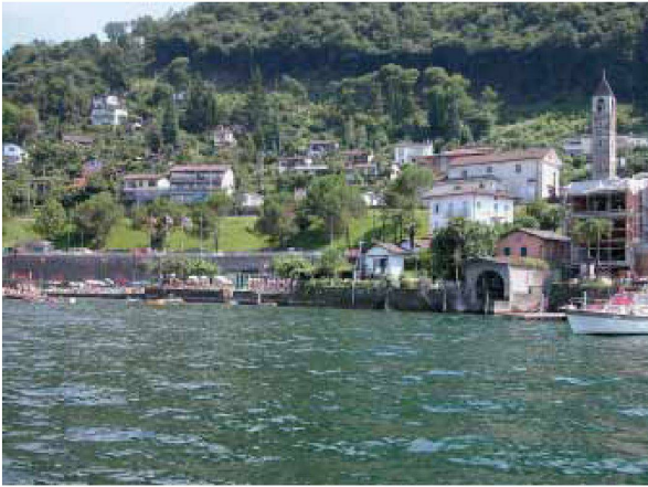
Bauplatz neben dem Strandbad Lido
