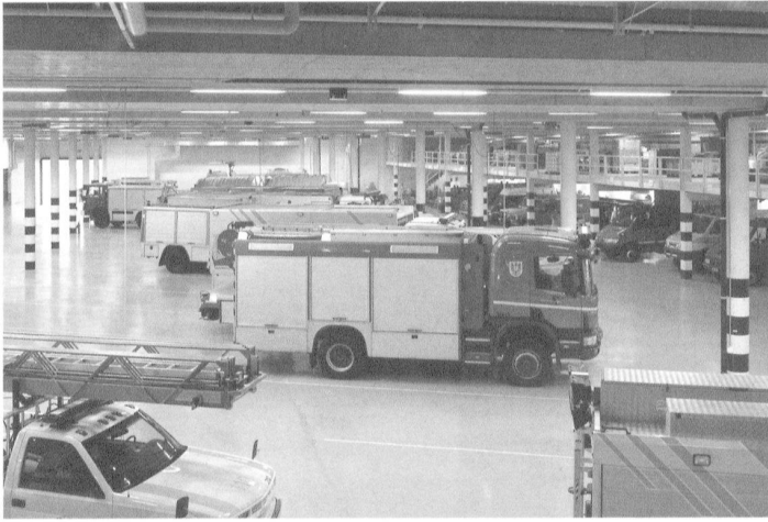
garage des pompiers, niveau 0
