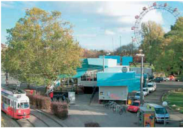
Links: Fluc, Fluc_Wanne, Um- und Zubau einer ehemaligen Fussgängerunterführung am Praterstern, Wien, von Klaus Stattmann. Prägende Materialien des Originalgebäudes: Stahlbeton, Raubeton, Gusseisengeländer. Prägende Materialien der Intervention: Standardcontainer, Stahlbeton, Stahlbau, Glas, zementgebundene Spanplatten, beschichtete Dachaufbauten in Holz-Leichtbauweise und Recyclingmaterialien für den Innenausbau.
