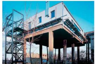
Links: Fluc. Fluc. Wanne. Um- und Zubau einer ehemaligen Fussgängerunterführung am Praterstern, Wien, von Klaus Stattmann. Prägende Materialien des Originalgebäudes: Stahlbeton, Raubeton, Gusseisengeländer. Prägende Materialien der Intervention: Standardcontainer, Stahlbeton, Stahlbau, Glas, zementgebundene Spanplatten, beschichtete Dachaufbauten in Holz-Leichtbauweise und Recyclingmaterialien
