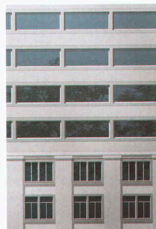
Fassadenausschnitt Krischanitz & Frank
