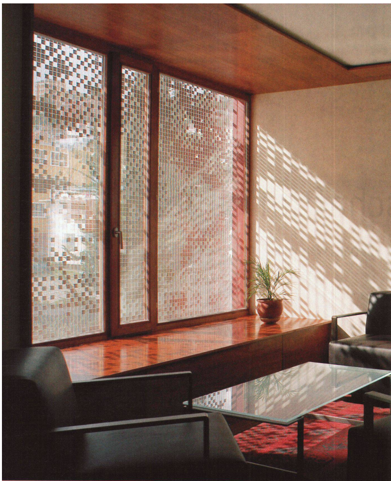
Moucharabieh aus Metallgewebe mit Aluminiumplättchen von innen (links) und von aussen (rechts); Eingangshalle (unten).
