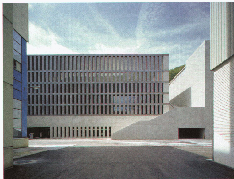
Sportgebäude als Befestigungs- und Zugangsbauwerk und obere Sporthalle
