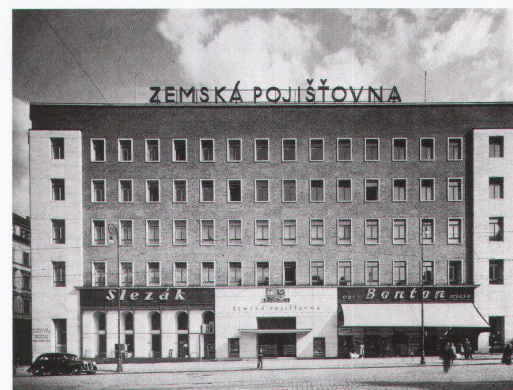
Umbau des Doret-Hofs für die Mährische Landeslebensversicherung, Brno, Malinovsky-Platz 4, 1934–1938.
