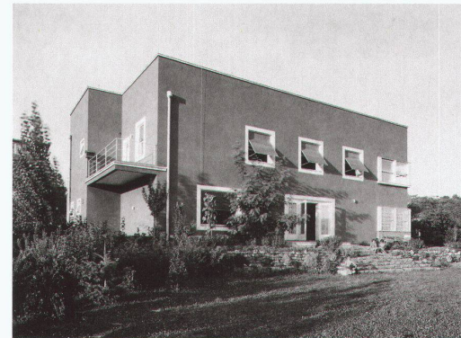
Villa Neumark, Brno, Vinařská-Str. 38, 1928–1929. Villa für den Textilfabrikanten und britischen Honorarkonsul Walter Neumark. Dies ist die zweite von Wiesners drei Brüner Luxusvillen, mit für ihre Zeit ungewöhnlich farbigen Fassaden, Grundrissen in L-Form mit einem Hauptwohnflügel und einem lotrecht dazu angeordneten Serviceflügel, mit einer Eingangshalle, einer geraden Einzellauftreppe längs der Eingangsfassade und mit einer Sala Terrena an der Ostseite des Bauwerks. Das für seine Zeit ungewöhnlich farbige und norditalienisch inspirierte Äussere kombiniert Wiesner in einer «dynamischen Symmetrie» gekonnt mit englischen Schiebefenstern.
