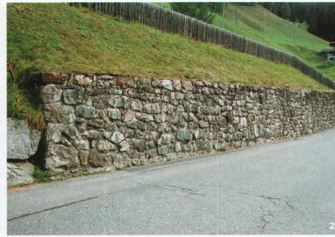
Bei der Abzweigung nach Eggen, Pt. 1649 beginnt eine Reihe von Mauern MX2. Die hohe Mauer in der Linkskurve ist von gleicher Qualität wie diejenigen unterhalb Clavadel. Sie weist zudem eine Krone mit Rollschicht auf (Abb. 12/13). Daran schliesst sich eine präzise gefügte Trockenmauer MT2 an (Abb. 14/15). Dies ist die zweite Zone traditionellen Charakters.
