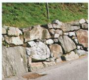
eine talseitige Zyklopenmauer mit Betonkordon abgelöst (Abb. 29). Auffällig ist die talseitige grobblockige Mauer MT1 an der Abzweigung nach «Gaschurna», über der feineren Mauer MX2 entlang der Hauptstrecke (Abb. 30/31). Nach der Kurve folgt eine weitere Zyklopenmauer in klassischer Trapezform (Abb. 32), die aber im Detail ein unbestimmtes Gefüge aufweist. Ihr oberer Abschluss wird durch kleine Steine gebildet (Abb. 33).
