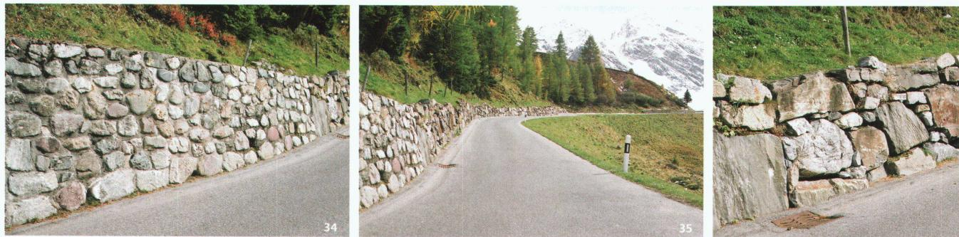
eine talseitige Zyklopenmauer mit Betonkordon abgelöst (Abb. 29). Auffällig ist die talseitige grobblockige Mauer MT1 an der Abzweigung nach «Gaschurna», über der feineren Mauer MX2 entlang der Hauptstrecke (Abb. 30/31). Nach der Kurve folgt eine weitere Zyklopenmauer in klassischer Trapezform (Abb. 32), die aber im Detail ein unbestimmtes Gefüge aufweist. Ihr oberer Abschluss wird durch kleine Steine gebildet (Abb. 33).
