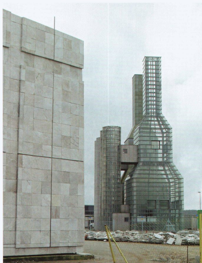
Hommage an Hejduk, Empfangsgebäude. – Bild: Markus Jakob
