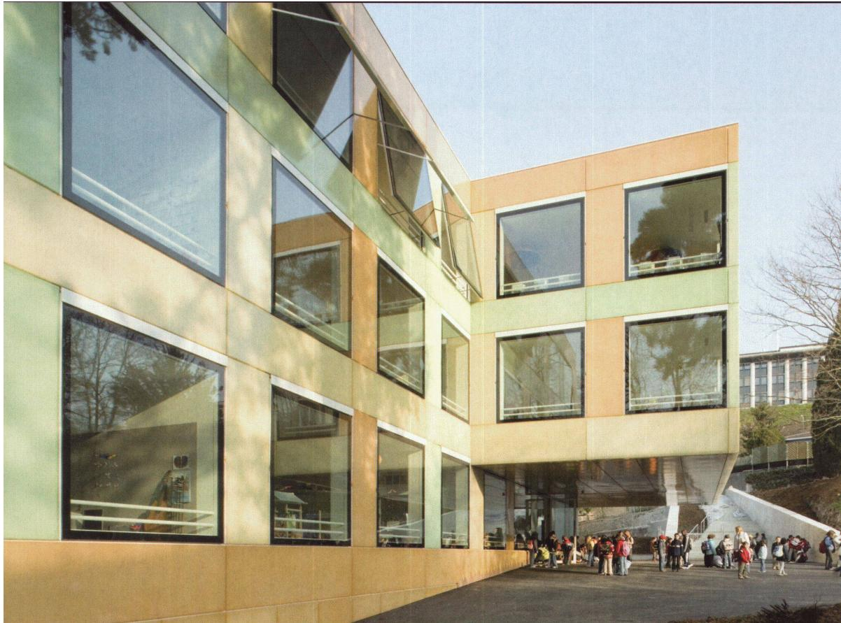
und einmal liegend angeordnet. Die leicht transluzenten Glasfaserelemente verleihen dem Gebäude eine unwirkliche Tiefe. Der Blick kann die physikalische Grenze des Materials nicht erfassen, sondern dringt in die farbige Masse des Baustoffs ein, der zur «Farbe» schlechthin wird, so dass der Baukörper eine ungewisse Tiefe entwickelt, die den Effekt der weiter oben erwähnten, fehlenden Wirkung nach aussen noch verstärkt.
