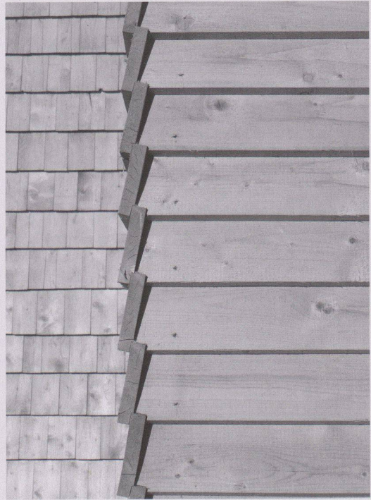
Schalung aus Bohlenbrettern
