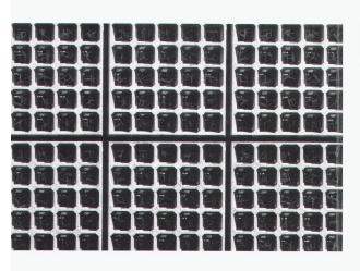
Schulhaus Mattenhof (wbw 3l2004) haben B.E.R.G. Architekten das Zweischalenbacksteinmauerwerk mit so vielen Möglichkeiten zur Ausdehnung gefügt, dass der über einem Netz aufgetragene Kellenwurfputz die so klein gehaltenen Bewegungen des Materials aufnehmen kann und höchstens Haarrisse in Kauf genommen werden müssen.
