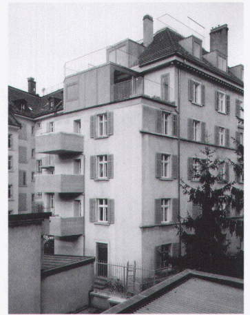
rechts: Umbau und Dachaufbau Josefstrasse Zürich, von Ballmoos Krucker Architekten 1997. Verarbeitung der Duripanelplatten in unregelmässigen, Restezulassenden Breiten. – Bild: Georg Aerni Grundriss oben und Bilder unten: Assisted Self-build housing, Tilbury 2001–2003. Bilder: David Grandorge
